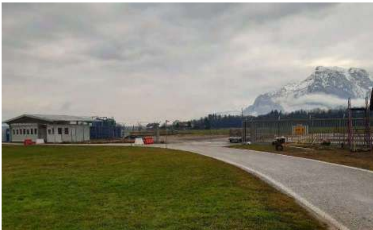
Flughafen Salzburg – Feuerlöschübungsgelände (© Umweltbundesamt)
